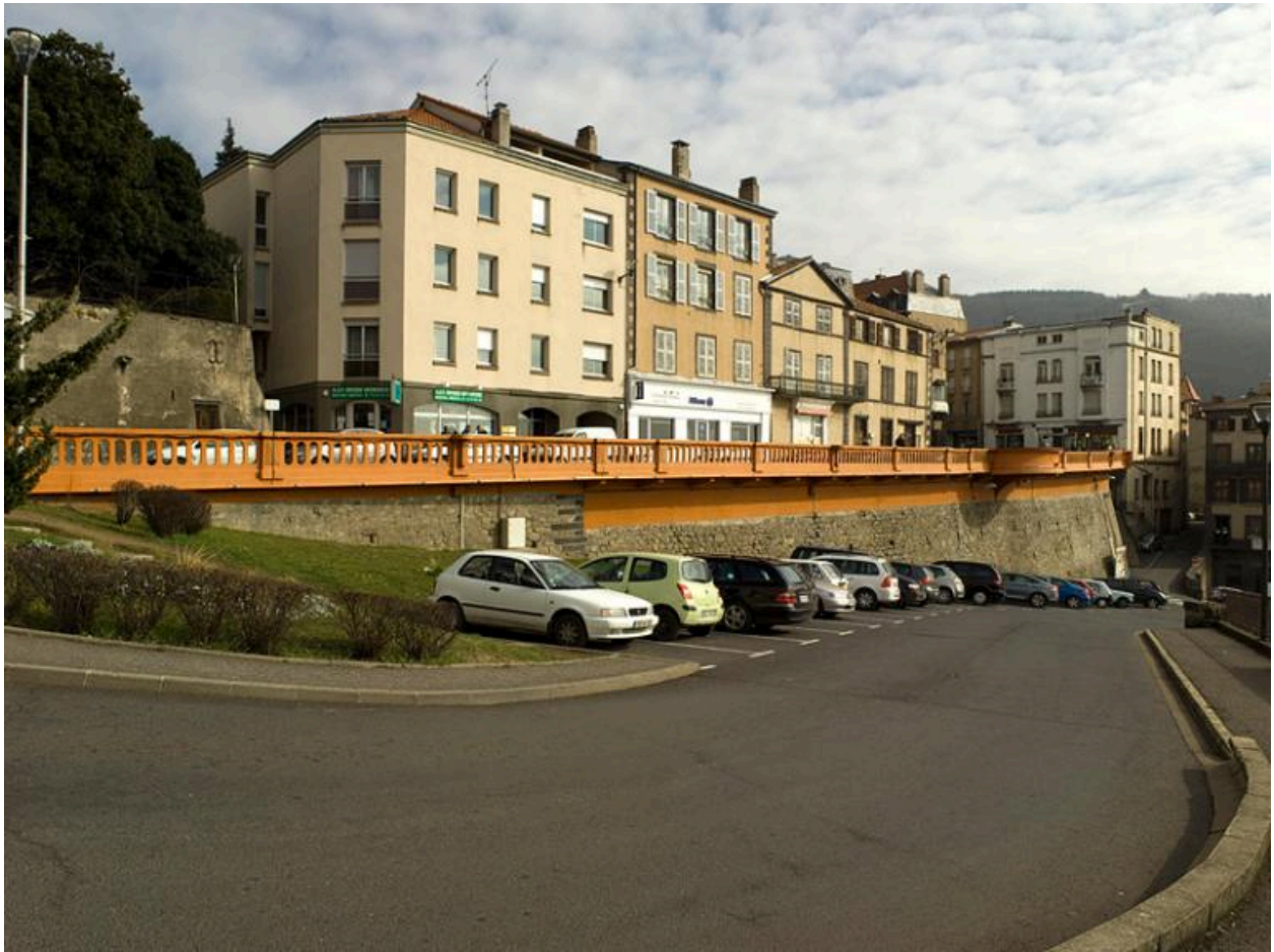
La rue et le mur de soutènement de la rue Terrasse, en direction du sud-est.
