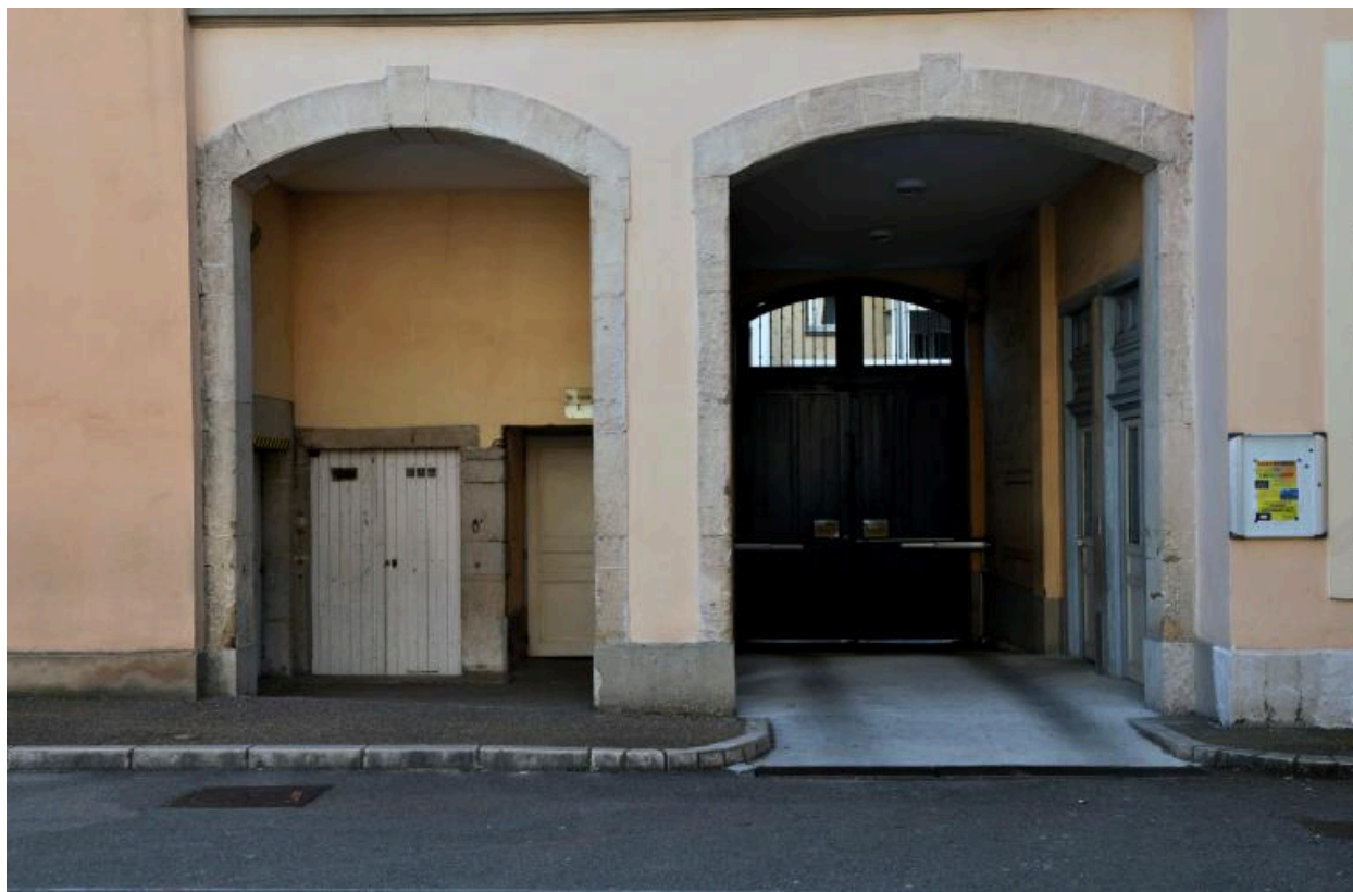
Bâtiment E : passage cocher vers la rue Schneyder
