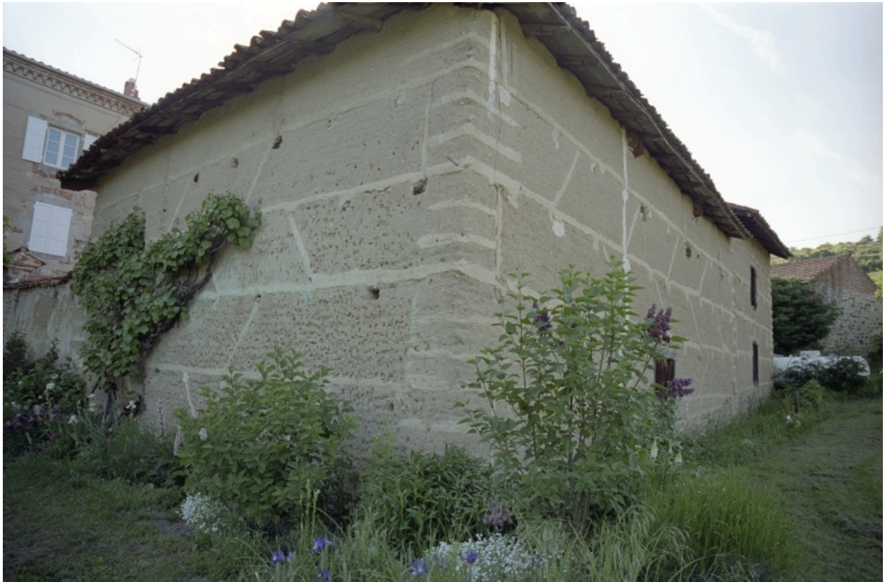
Détail du pisé sur les murs latéral et postérieur de la grange.
