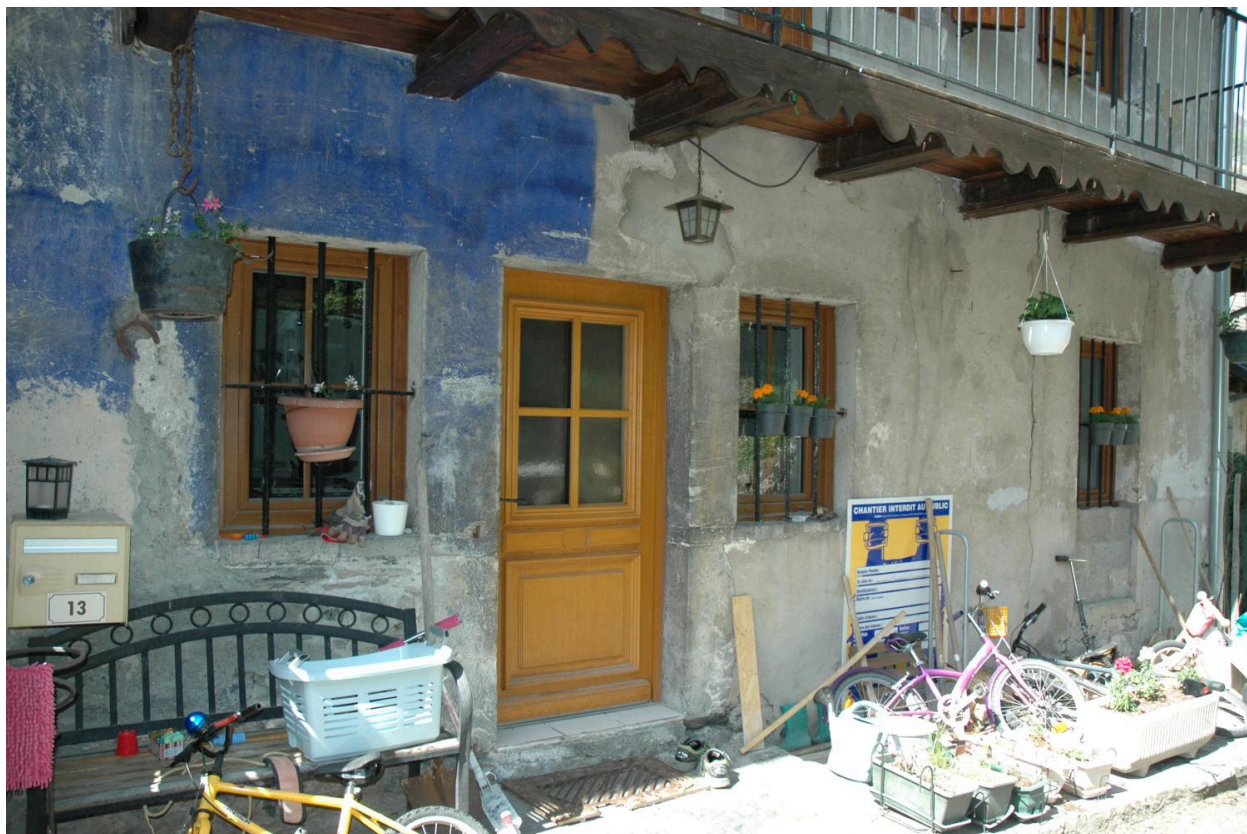
Maisons de vigneron (2018 A5 1043, 1193), rez-de-chaussée surélevé.
