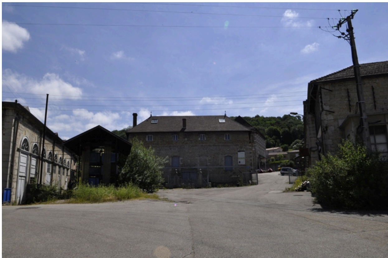
Vue extérieure de la forge
