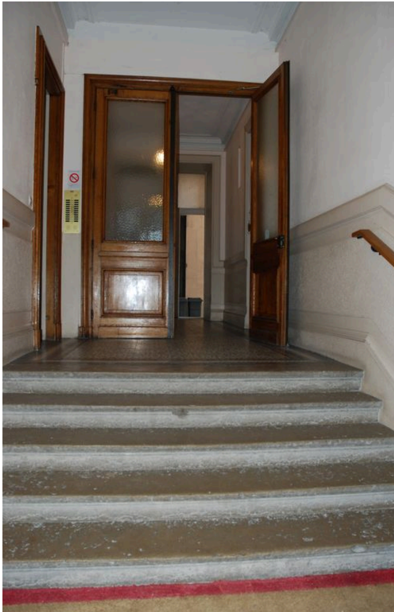
Vue intérieure : vestibule surélevé et porte du sas
