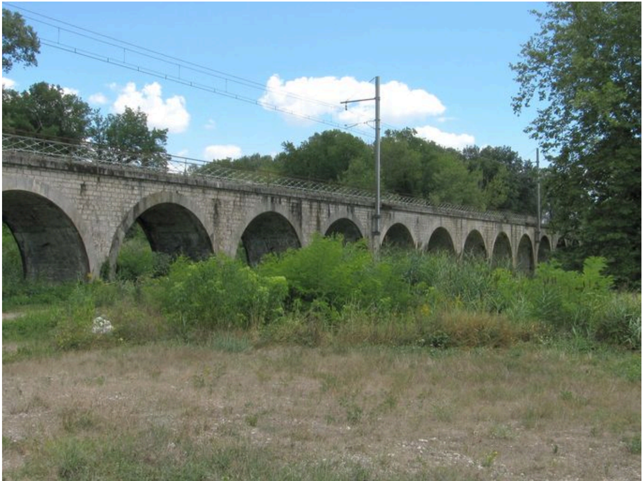
Vue générale du pont, face aval
