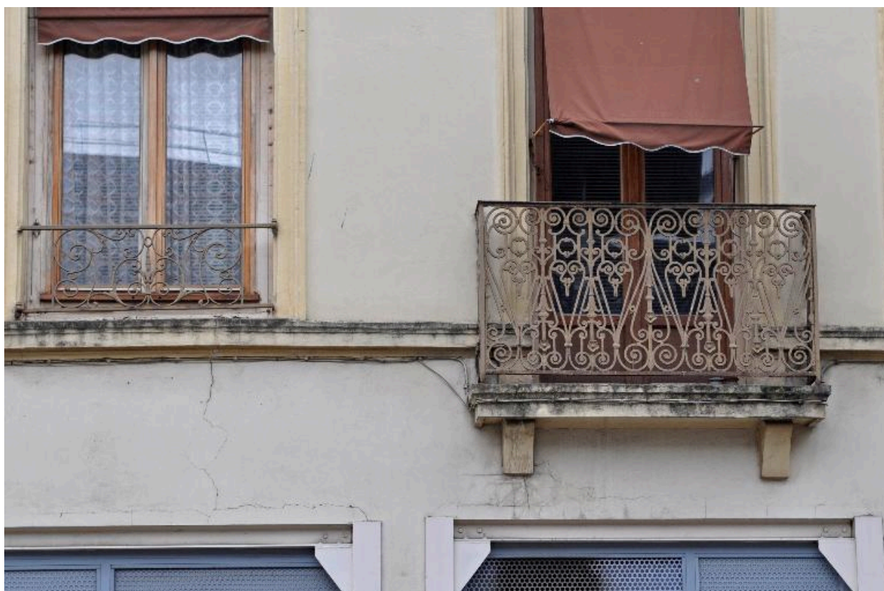
Détail du balcon du premier étage
