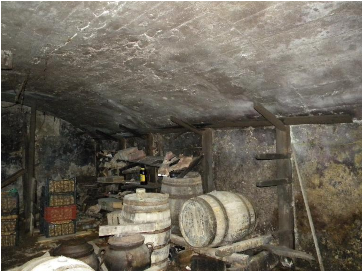
Vue de la cave dans la dépendance agricole du moulin.
