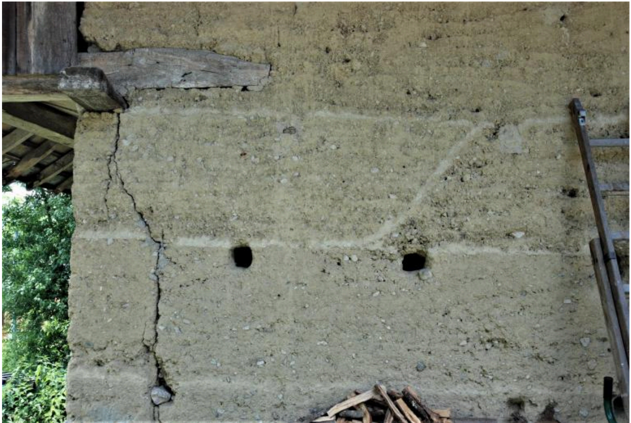
Mur pignon, détail du pisé.
