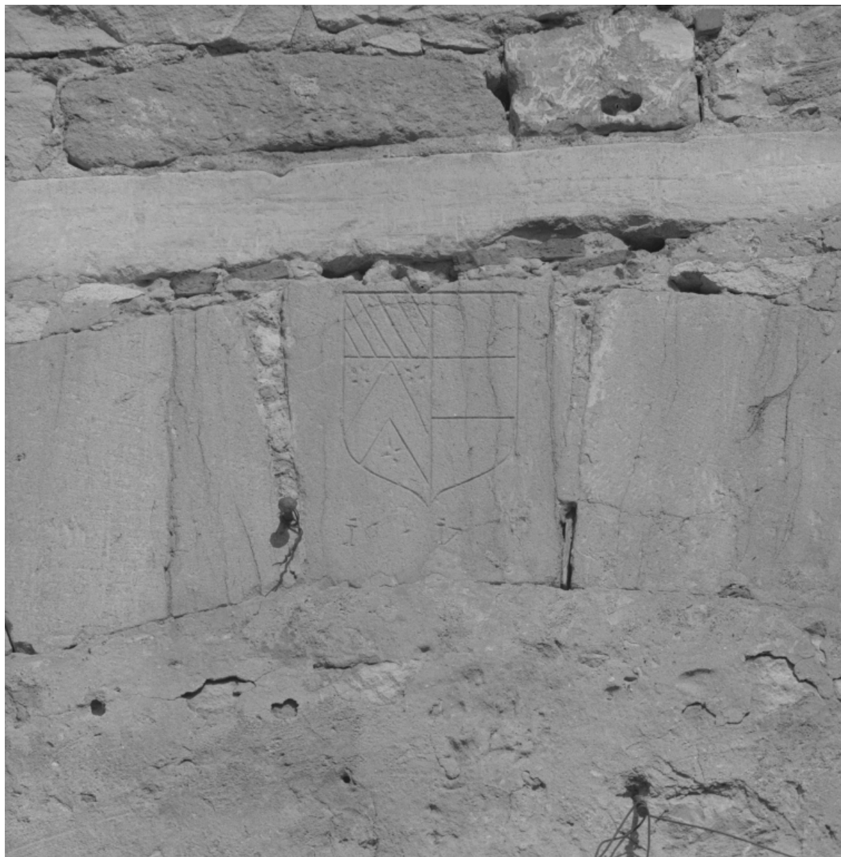
Aile gauche, élévation postérieure, détail armoiries gravées à la clef de l'arc.
