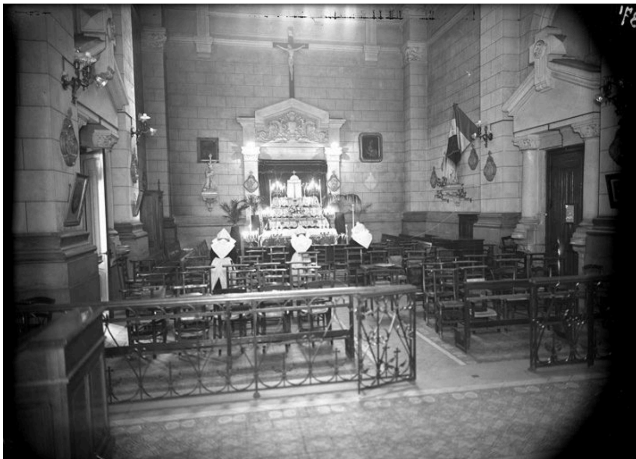
Debrousse intérieur chapelle, vue de l'entrée à l'est, fotogr., ca 1910-1950
