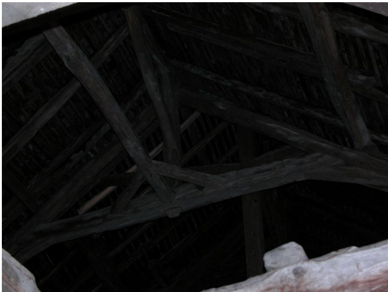
Détail de la charpente de la grange.
