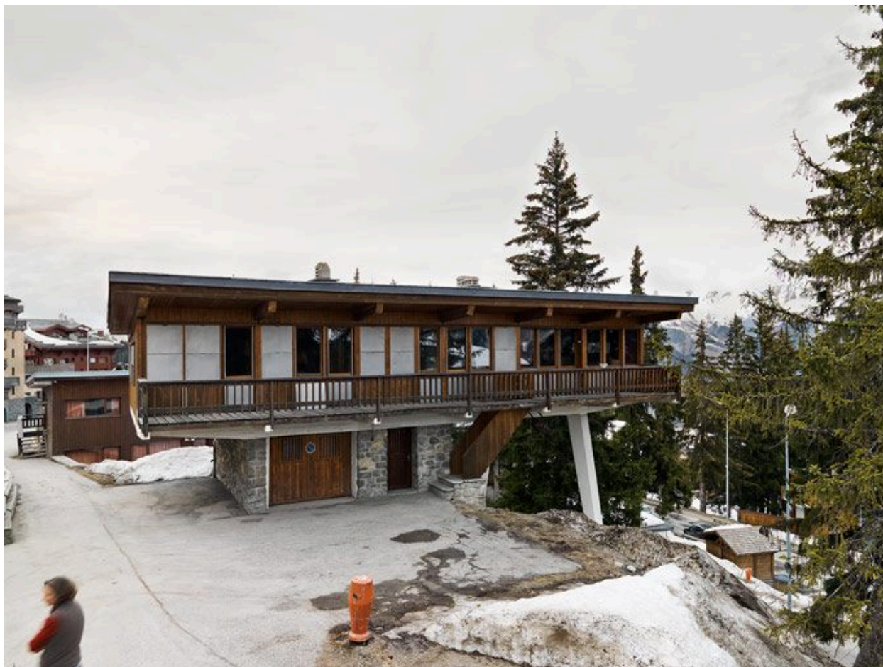
Vue de la façade sud
