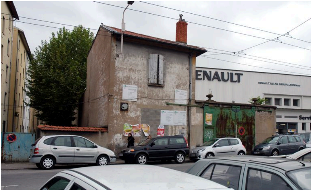
Vue de l'élévation latérale nord
