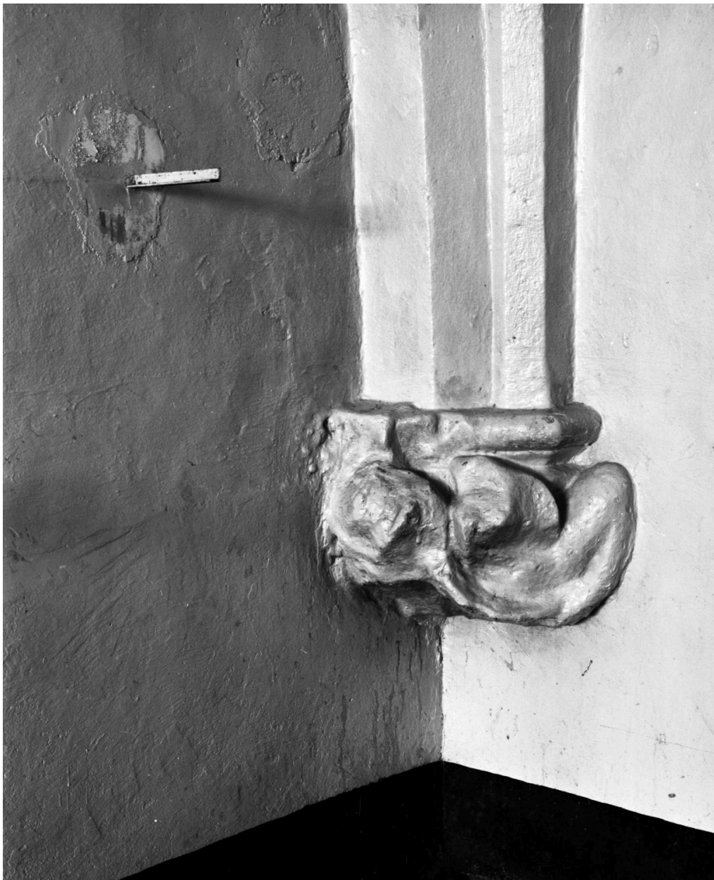
Détail d'un culot sculpté portant une ogive de la voûte de l'église des cordeliers, dans un dortoir du bâtiment B, la nef ayant été divisée dans la hauteur.
