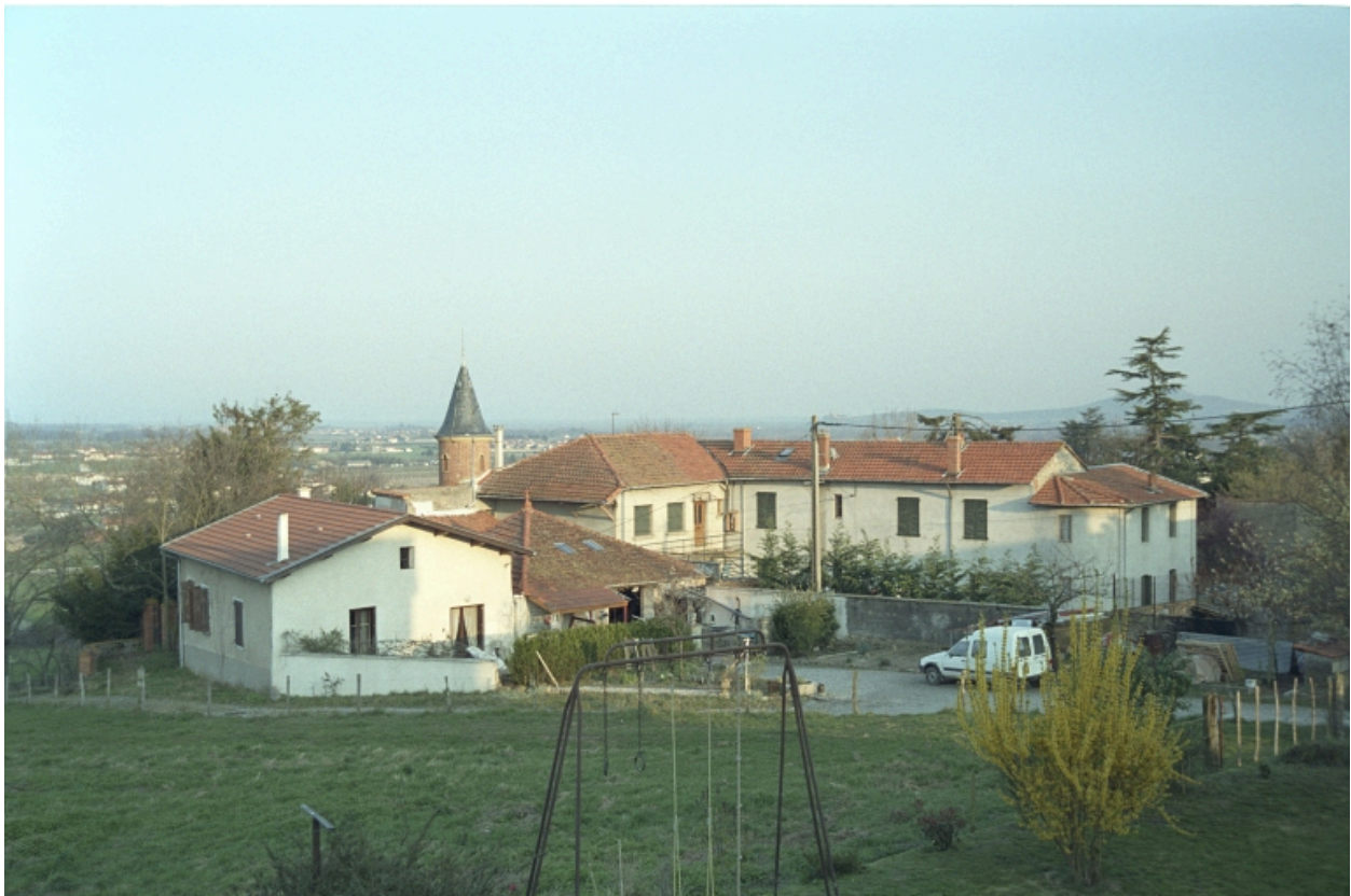
La Chaux Est, maison bourgeoise dite Château de la Chaux, section E 217, 288. Vue d'ensemble des bâtiments.
