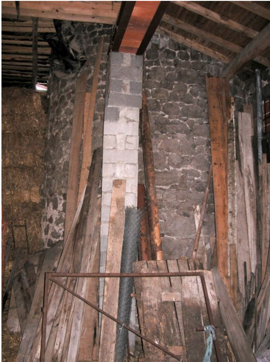
Détail de la base de la tour d'escalier hors-oeuvre.
