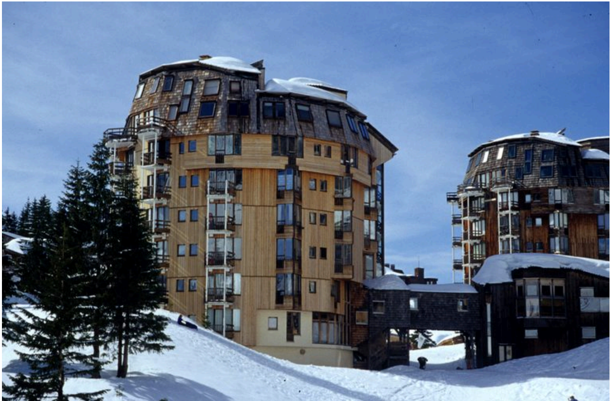
Vue depuis l'est avec la passerelle couverte vers le pavillon central démolie en 2000
