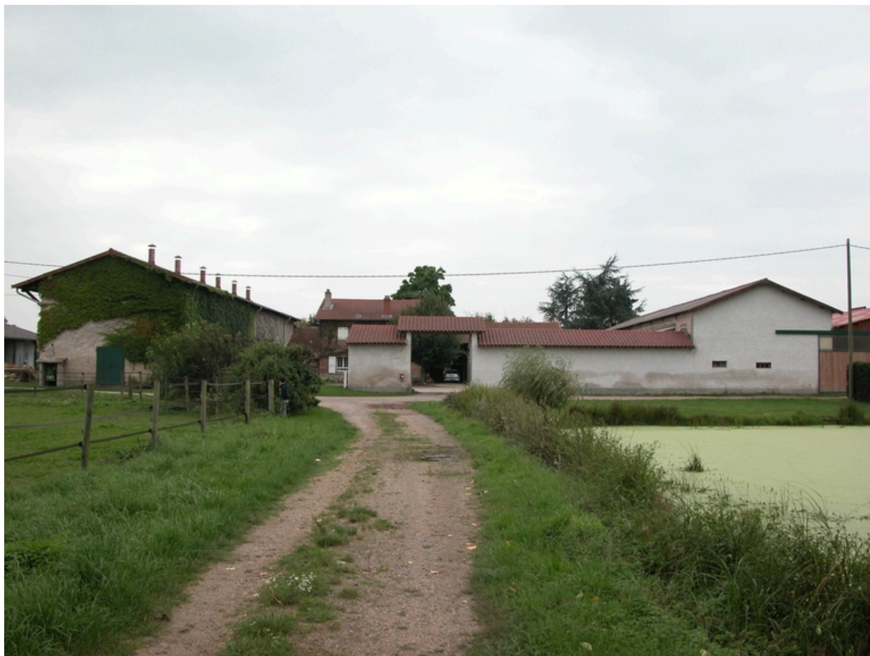
Vue générale depuis l'est.
