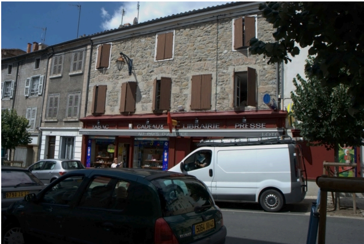
Îlot 4. République (place de la) 26. Vue générale de la façade sur la place.
