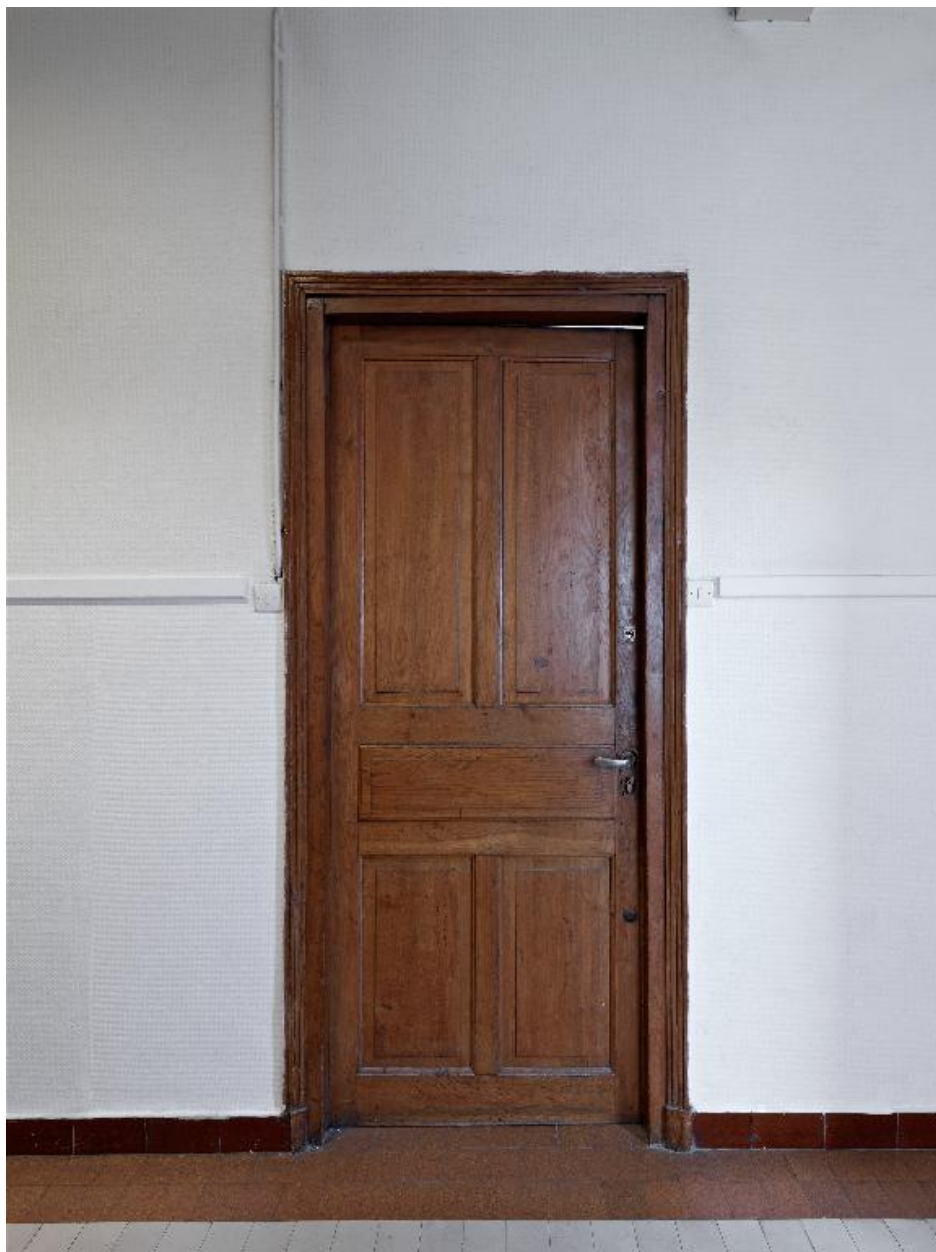
Porte d'un logement de fonction, 4e étage
