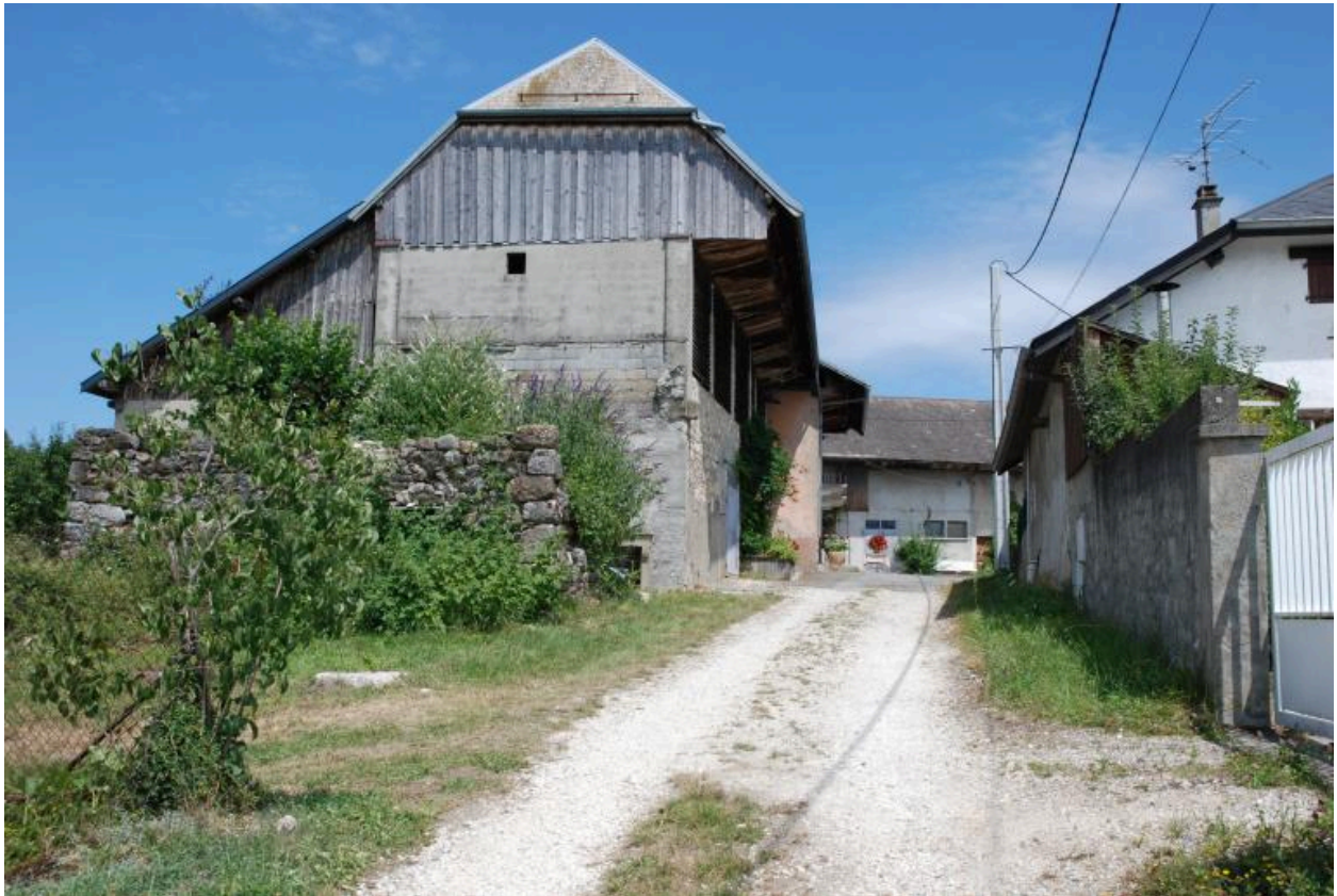
Vue de l'entrée ouest du hameau (à gauche, ferme IA74002764).
