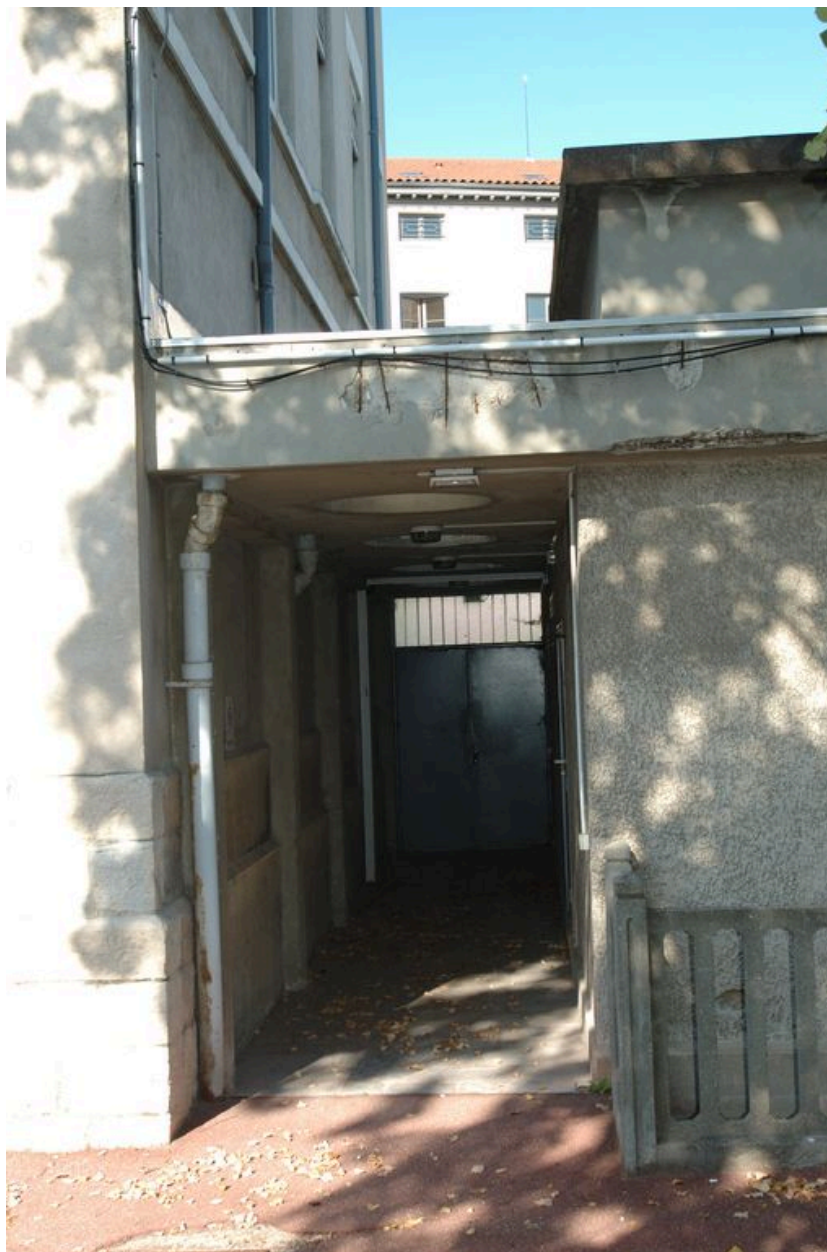
Vue, en octobre 2011, du passage entre la chapelle et la morgue, devant être détruit.
