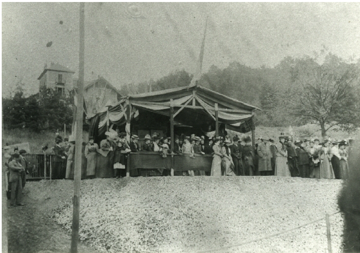
Pose de la première pierre, tribunes
