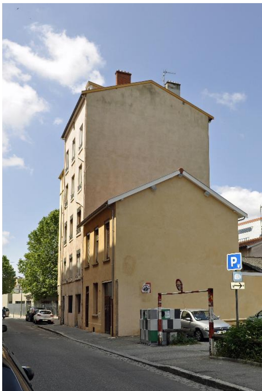
Vue de l'élévation latérale nord
