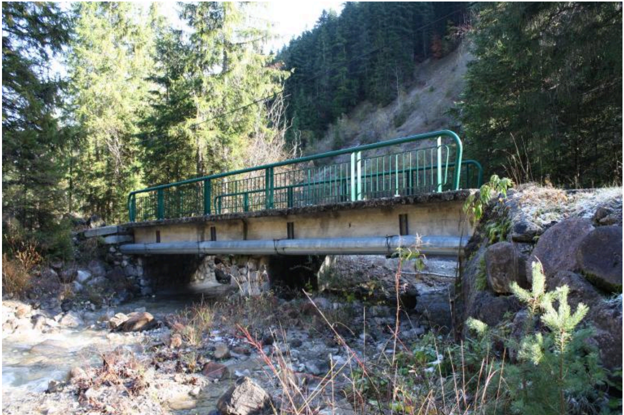
Pont de Crêt, face amont
