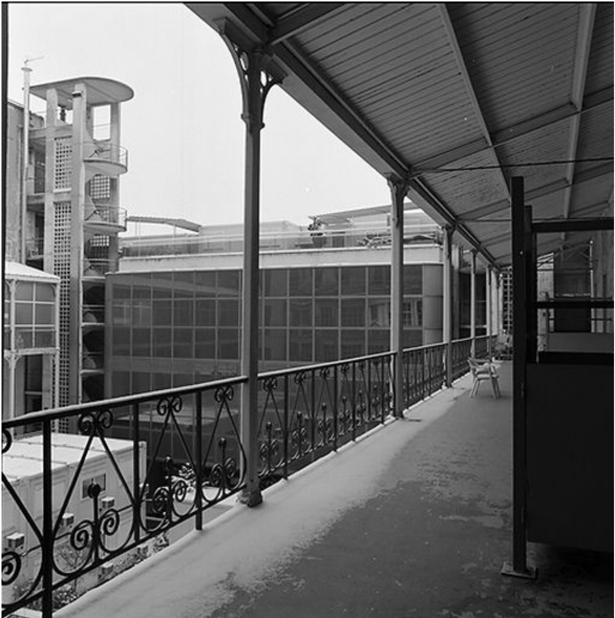
Bâtiment principal, aile sud, 2e étage de la galerie
