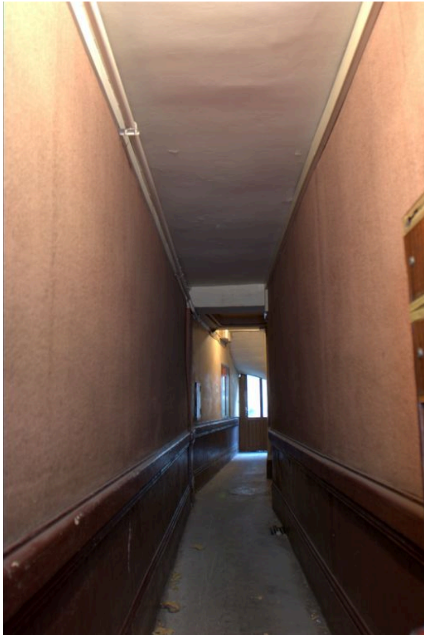
Vue du couloir d'entrée depuis la porte de l'immeuble
