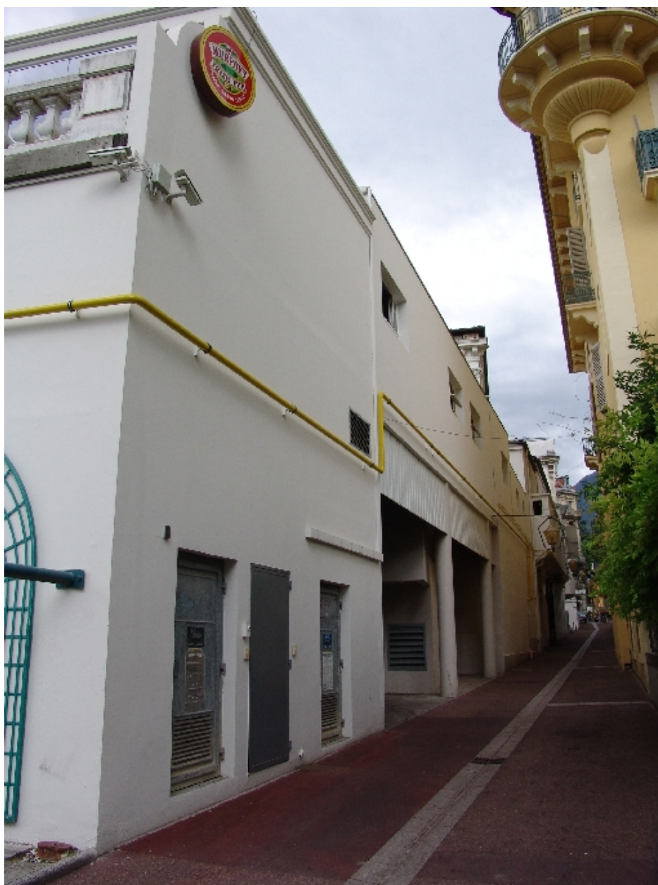
Façade latérale sud
