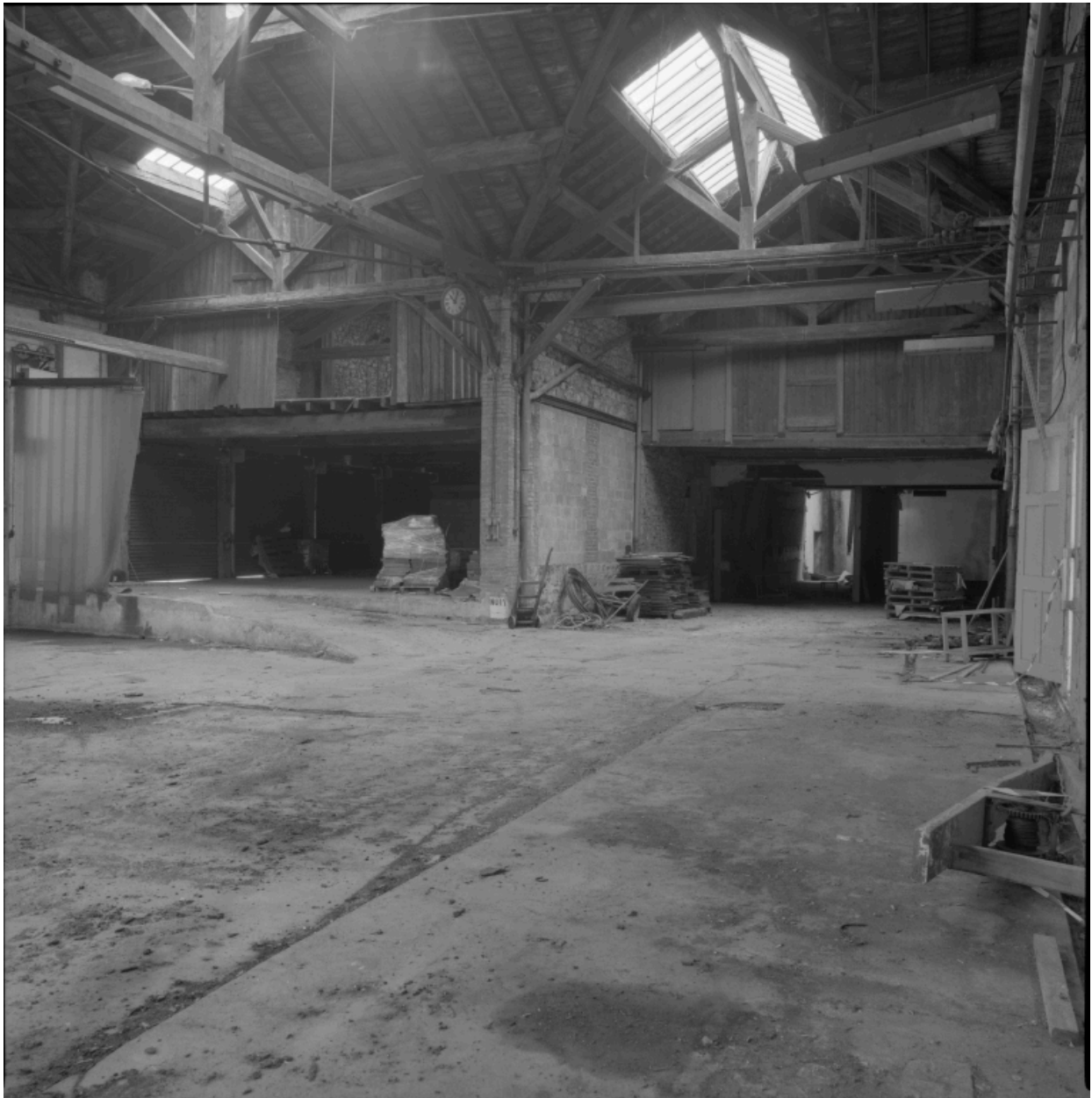
Vue d'ensemble intérieure de la cour couverte et des quais de l'usine de mise en bouteille des eaux minérales.
