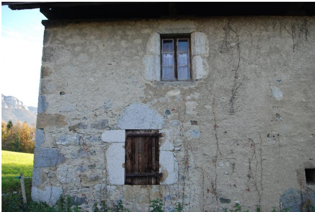
Détail des baies du logis sur la façade arrière de la ferme.
