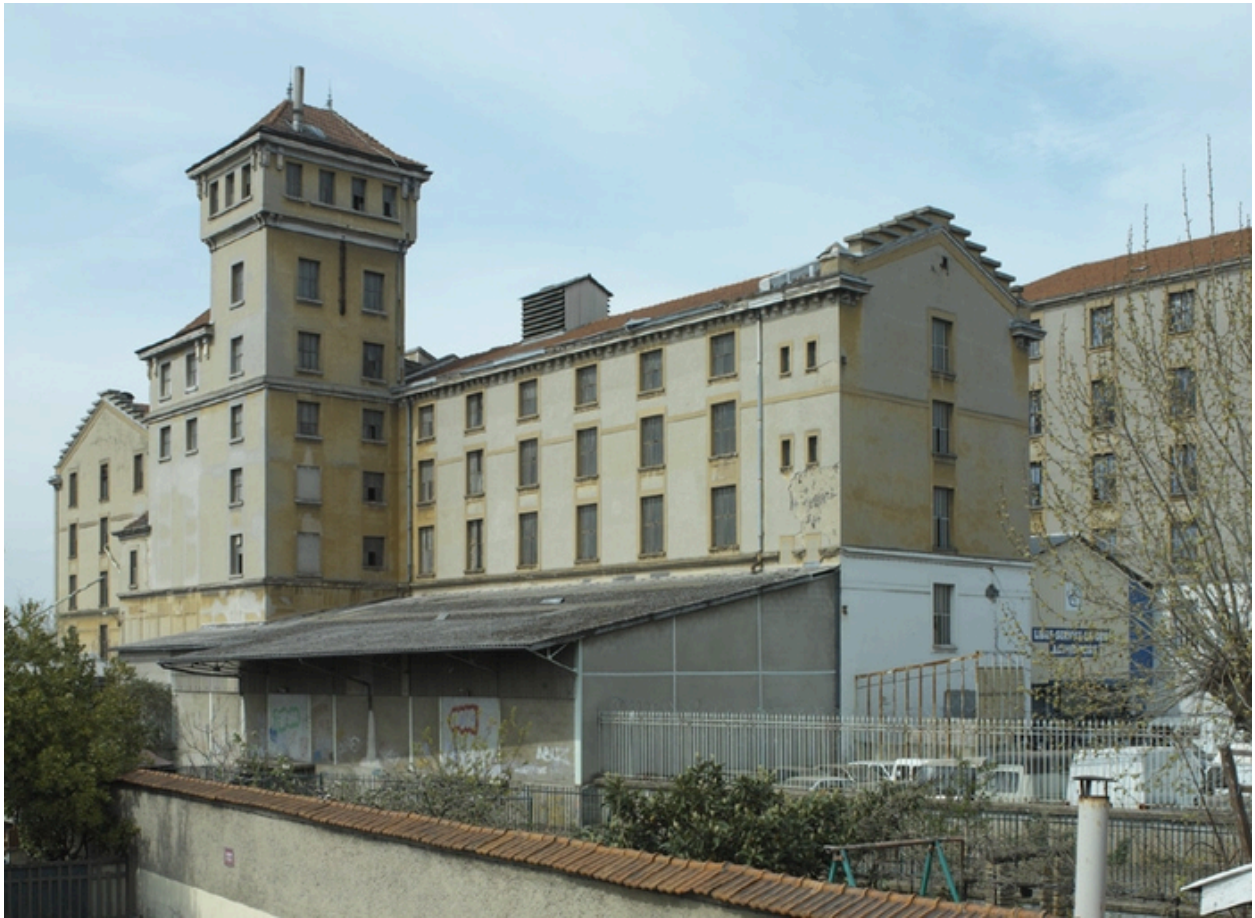
Vue du silo
