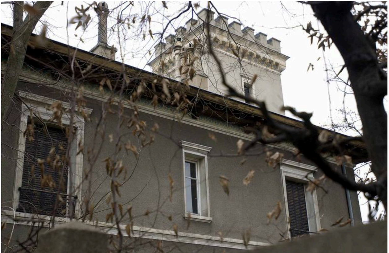
Logis, détail de la façade latérale sud
