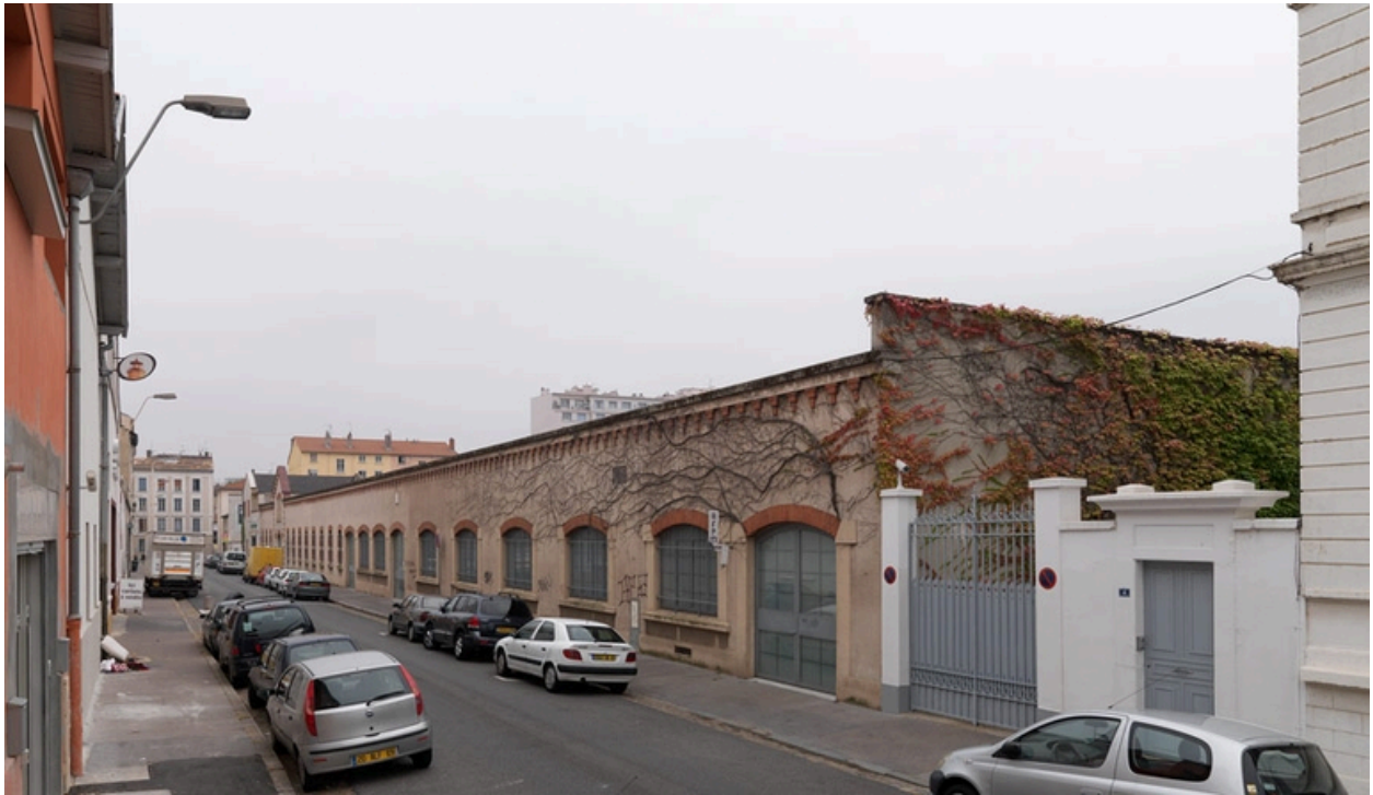
Façade principale ouest
