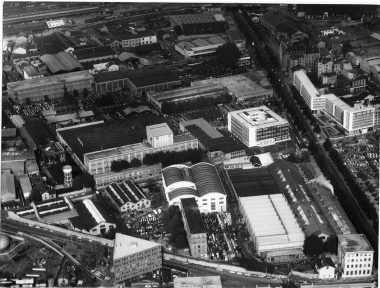
Vue d'ensemble du site dans les années 1970, archives privées de la société Nexans
