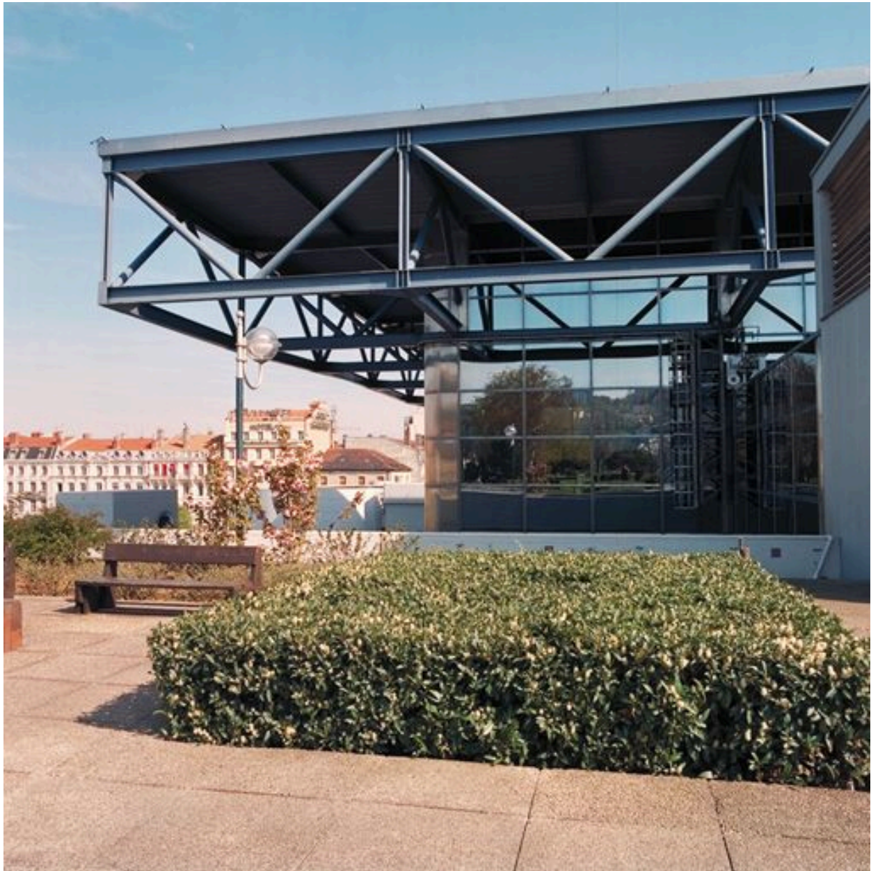
Détail de la charpente métallique et de la façade miroir : transparence et reflets
