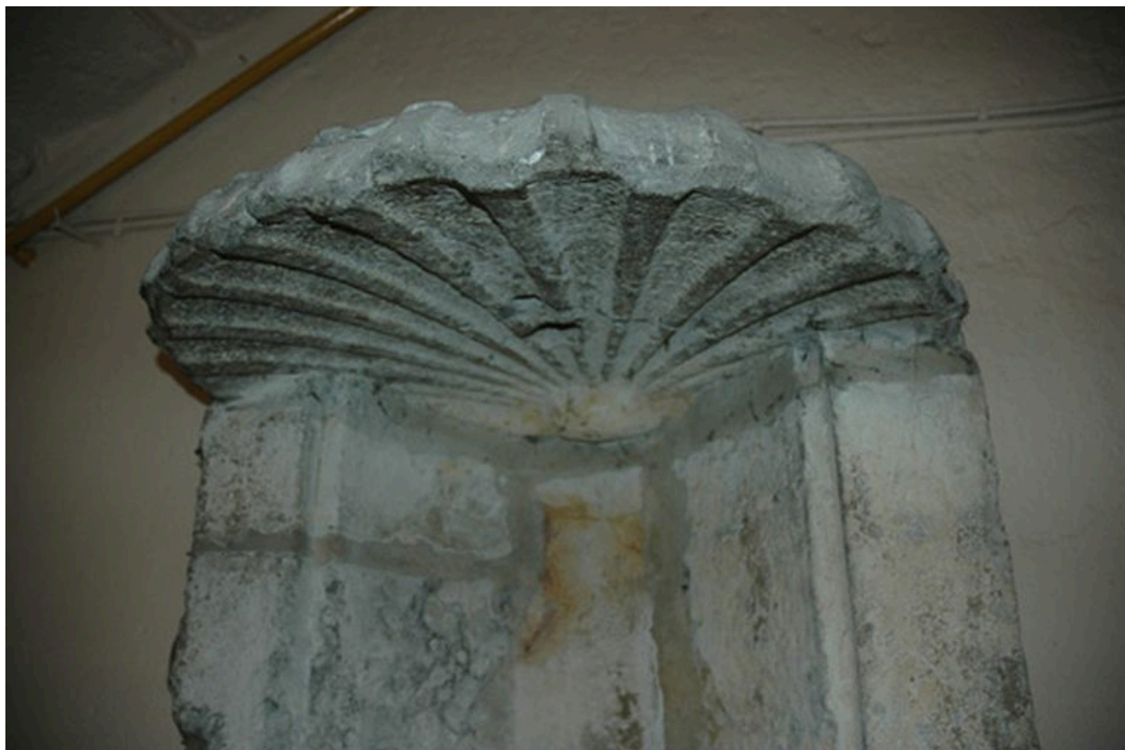
Couvent : 12 place Antonin-Gourju, détail du puits
