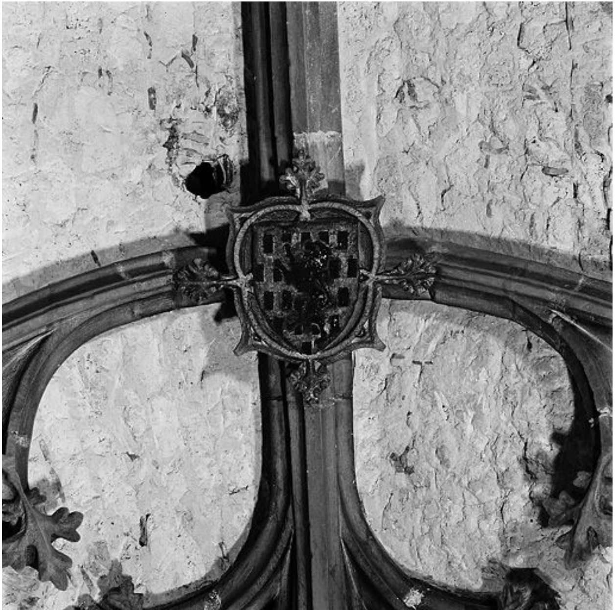
Voûte du vaisseau central en cours de restauration en 1977, travée VI, détail d'une clef de voûte secondaire aux armes de l'archevêque de Lyon Guillaume de Sure
