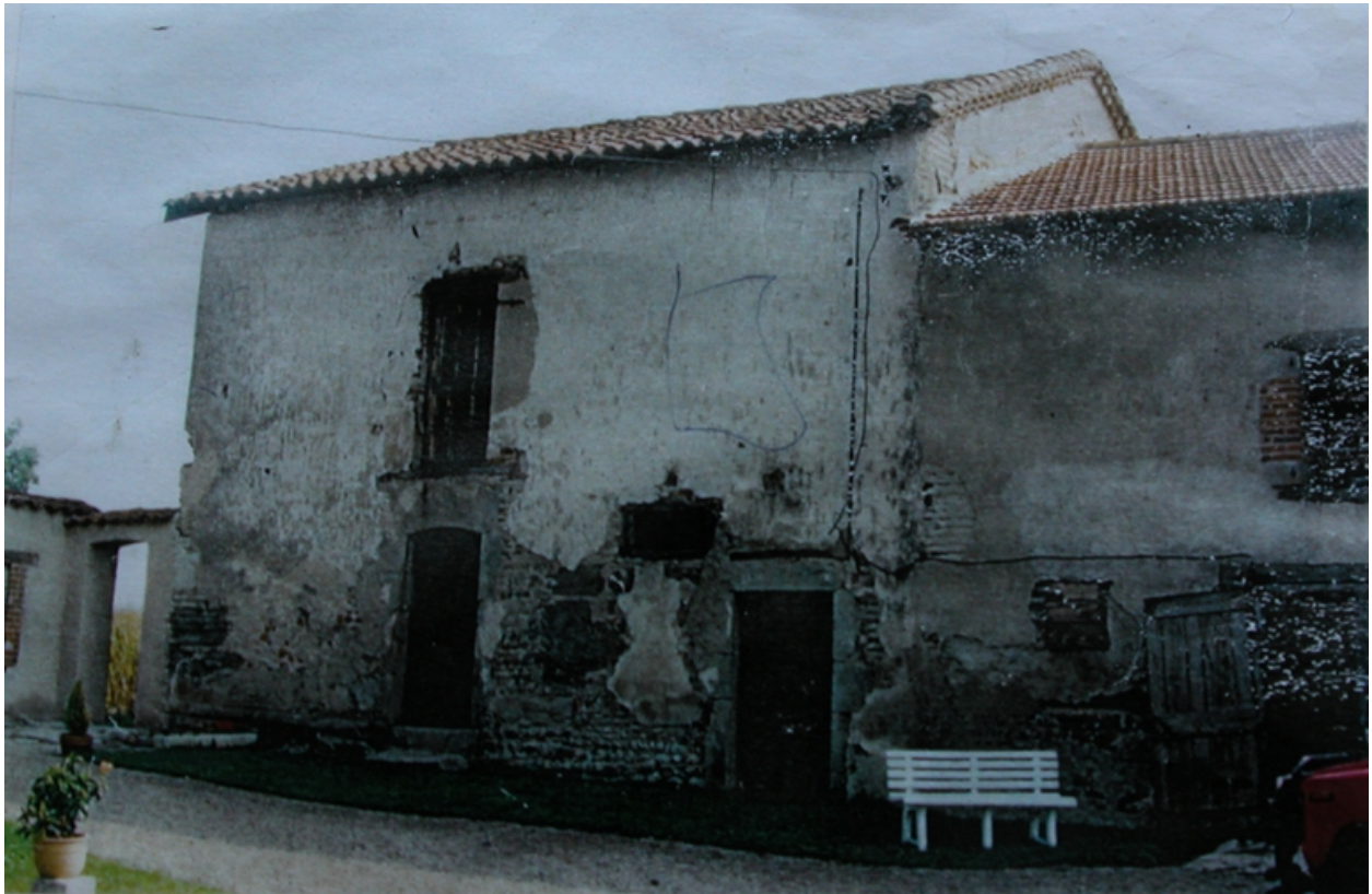
Vue du bâtiment est (sellerie), depuis le sud-ouest, avant transformation. 4e quart 20e siècle.
