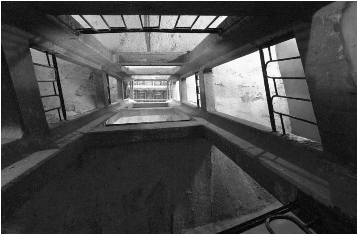
L'escalier à quatre noyaux en contre-plongée
