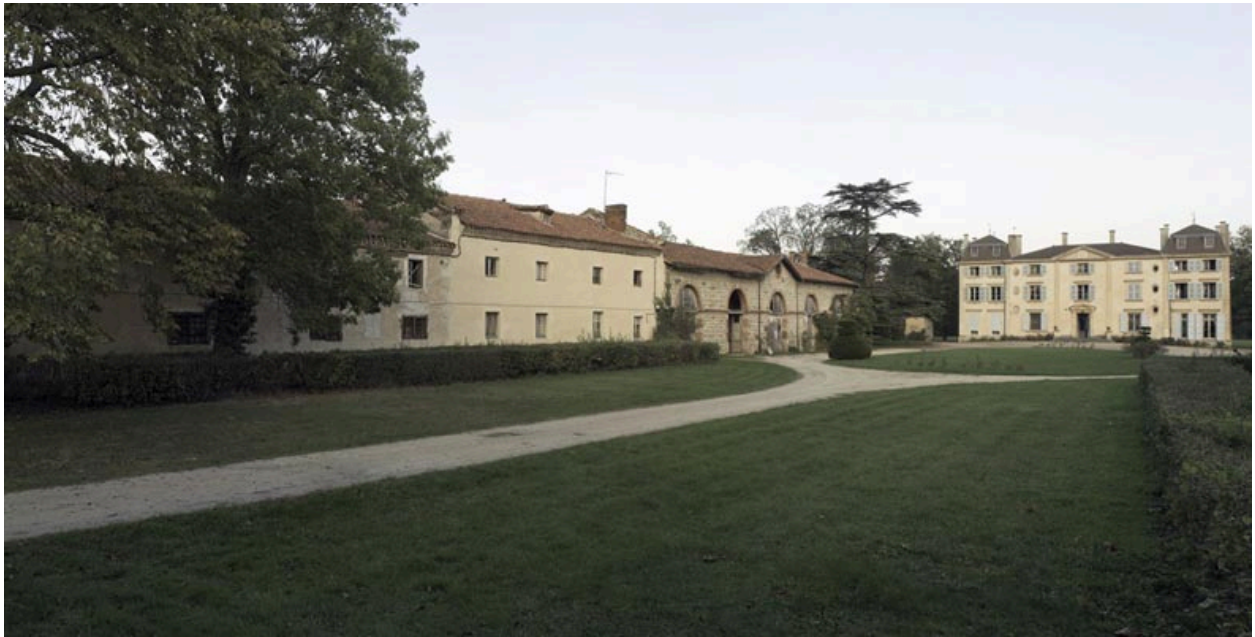
Corps de communs nord : vue générale depuis la cour d'honneur, du sud-ouest.
