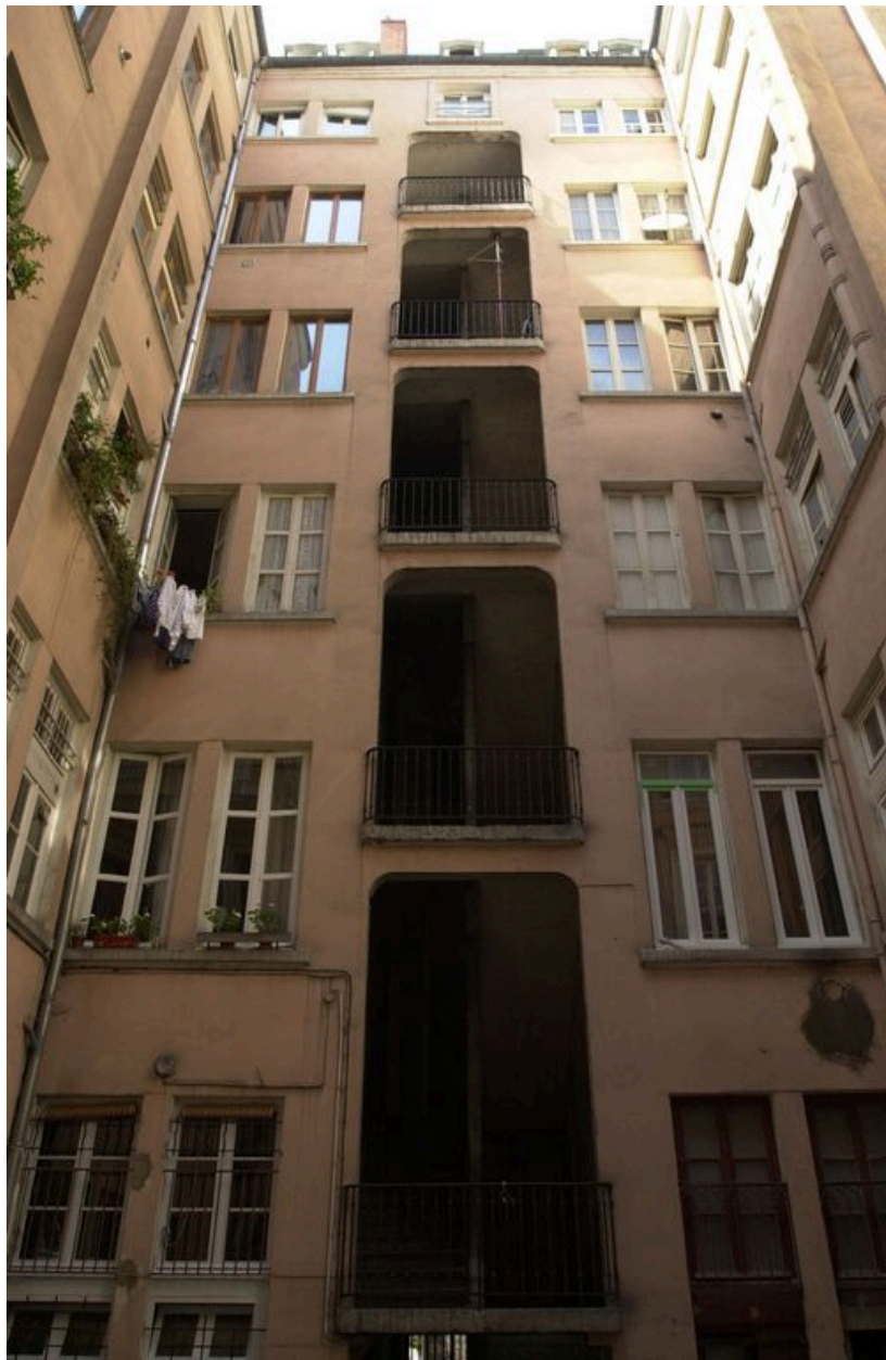
Vue de la façade sur cour
