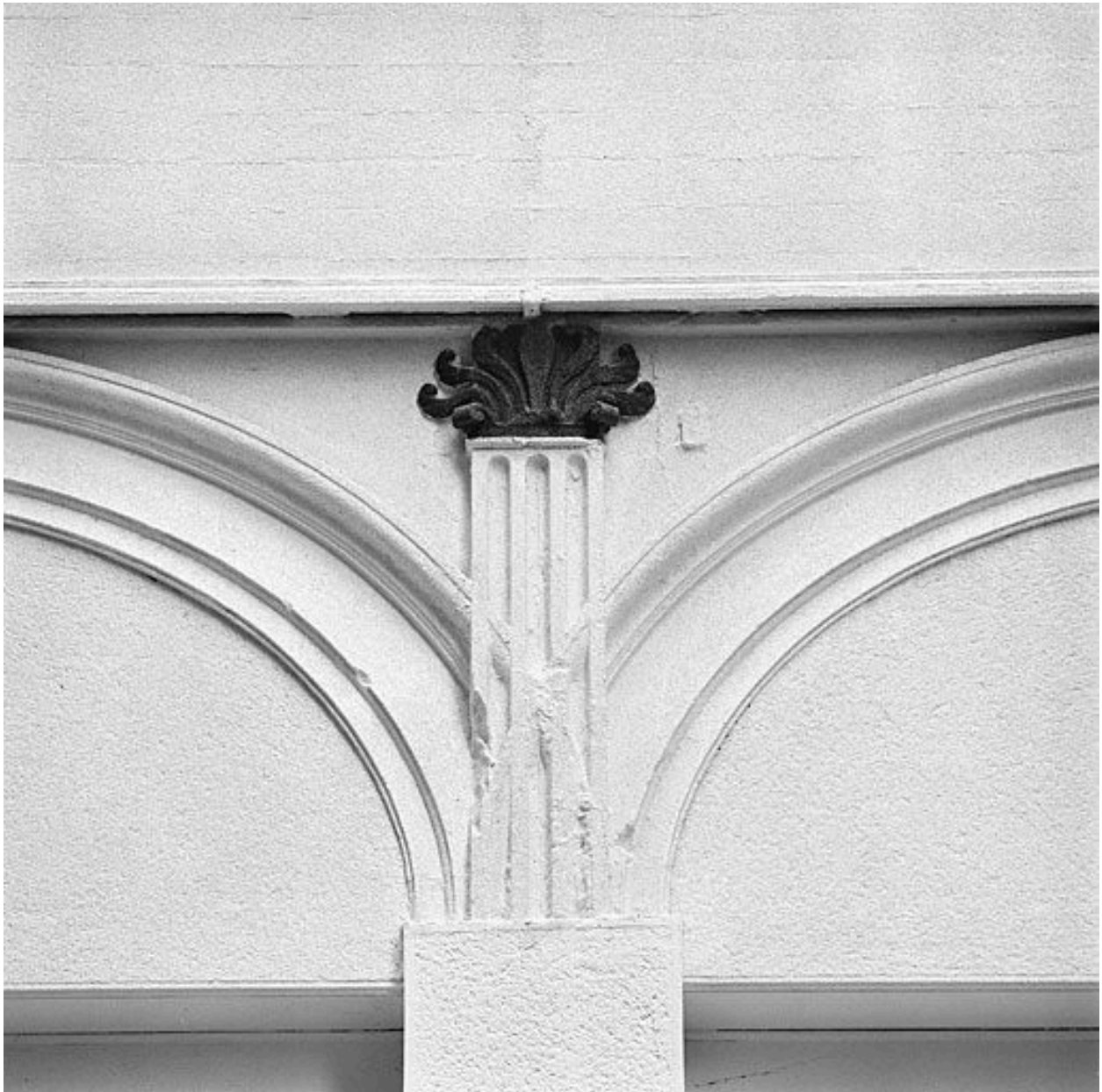
Rue de la Monnaie : devanture de boutique, détail de l'intersection des arcs moulurés et du pilastre cannelé, 1976
