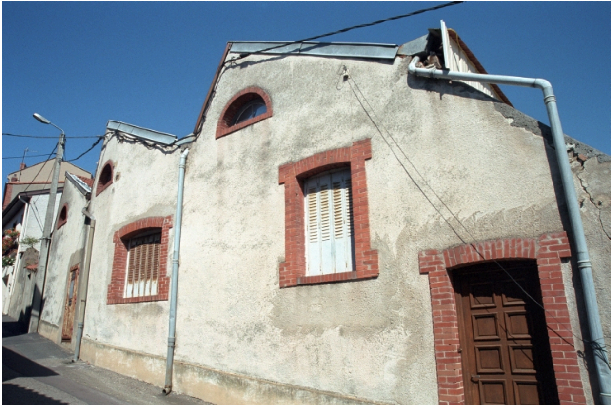
Vue générale des bâtiments industriels.
