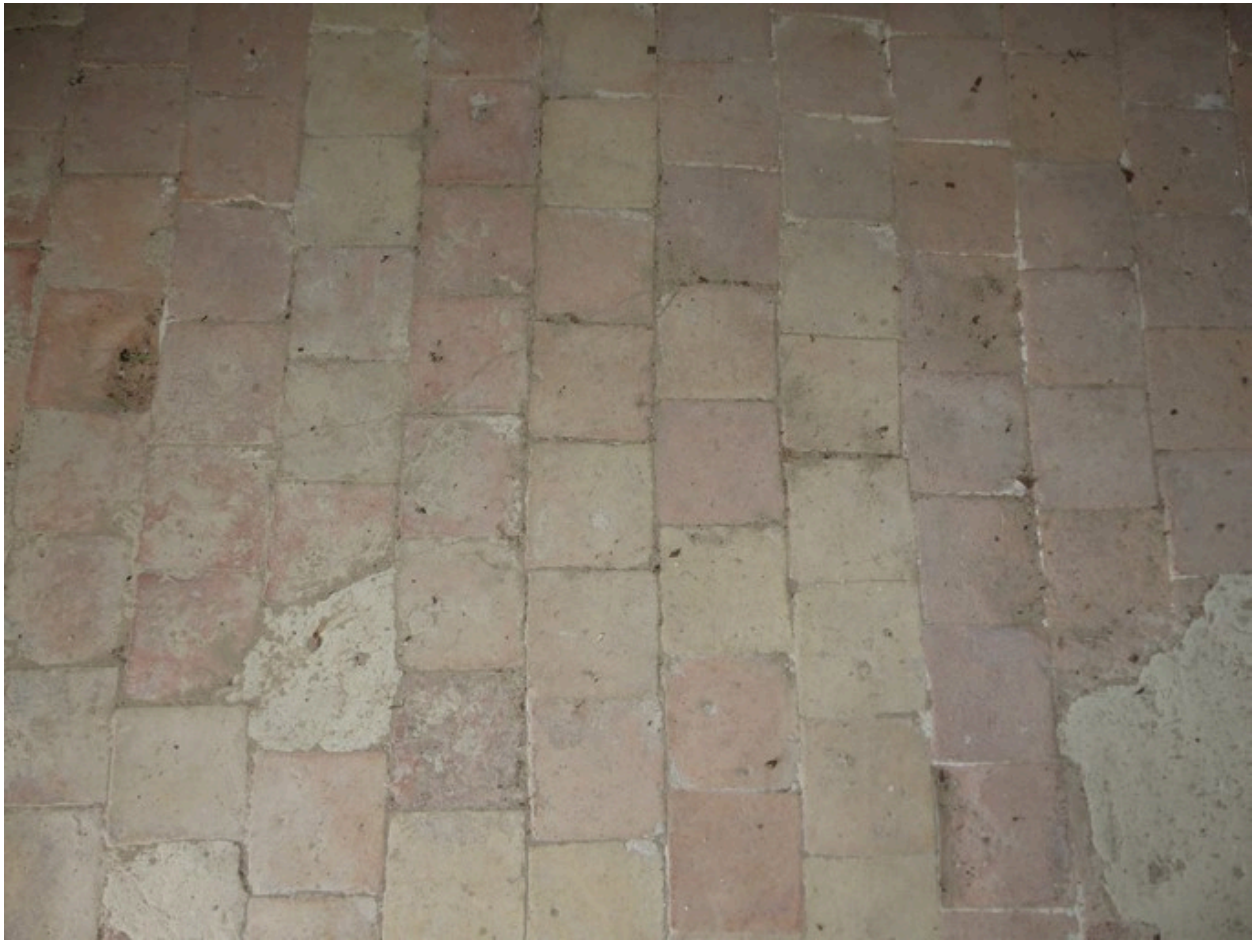
Rez-de-chaussée surélevé, chambre puis séchoir. Sol en carreaux de terre cuite.
