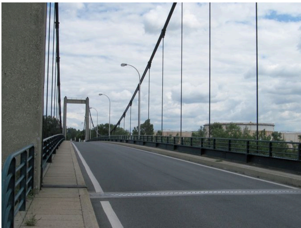
Chaussée (depuis la rive droite)
