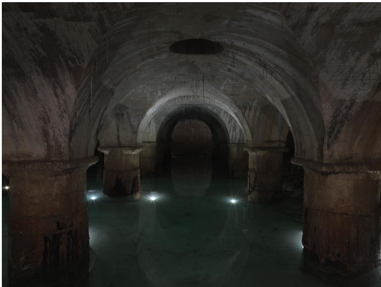
Vue des bassins filtrants
