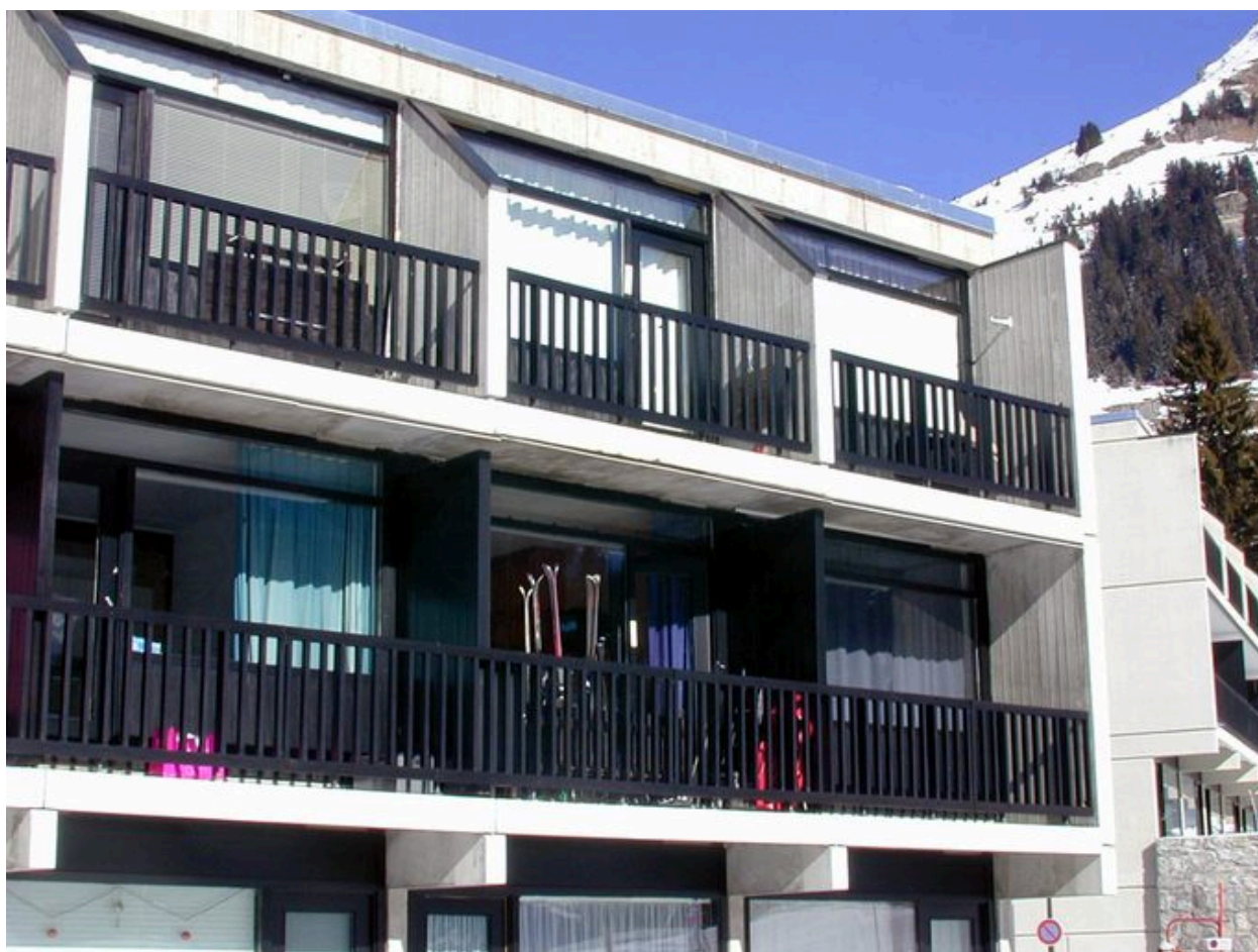
Les balcons sud
