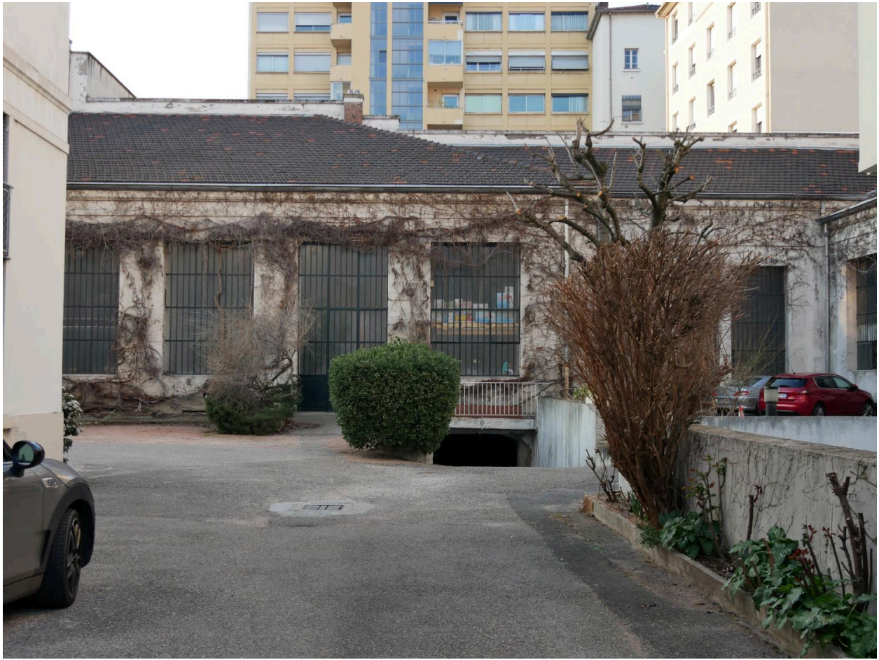
Entrepôts sur cour
